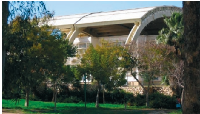
Dach antyrakietowy nad budynkiem szkoły podstawowej w Sderot.
